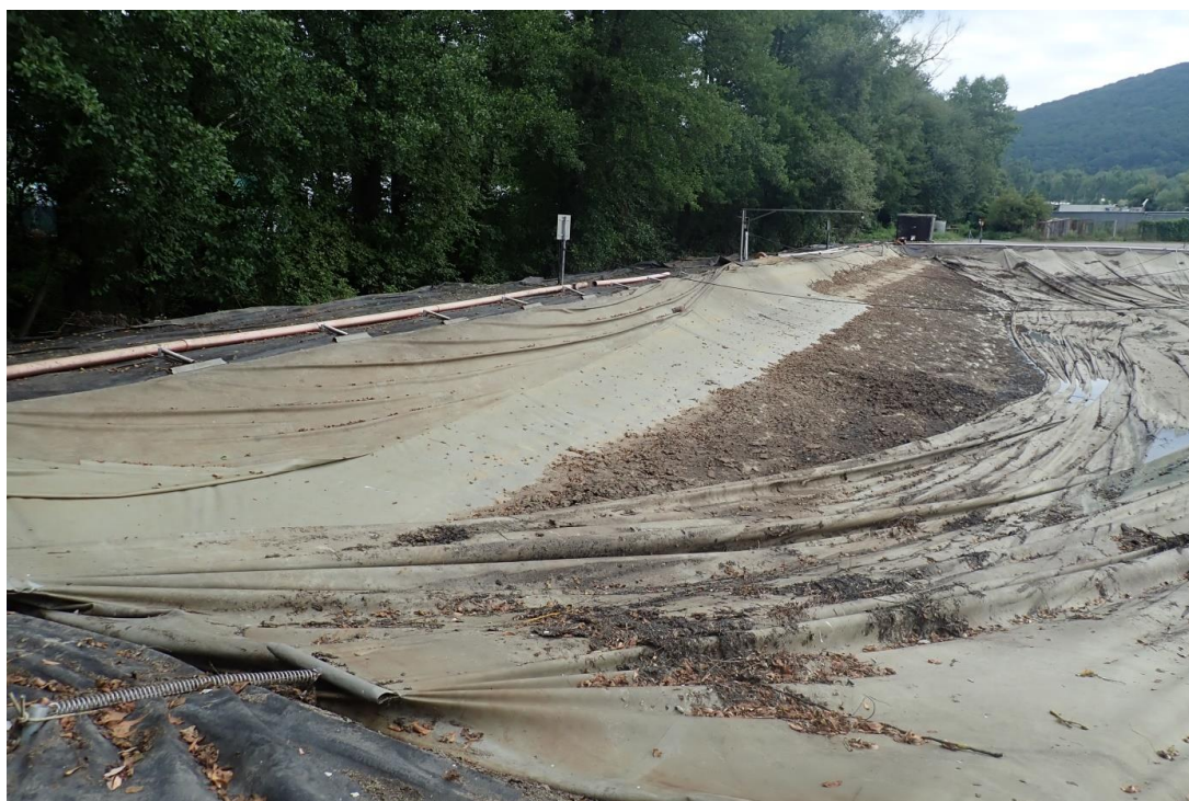
Fotografia č. 4 Bag tank dňa 10.08.2021 – po vyčerpaní uskladneného digestátu
