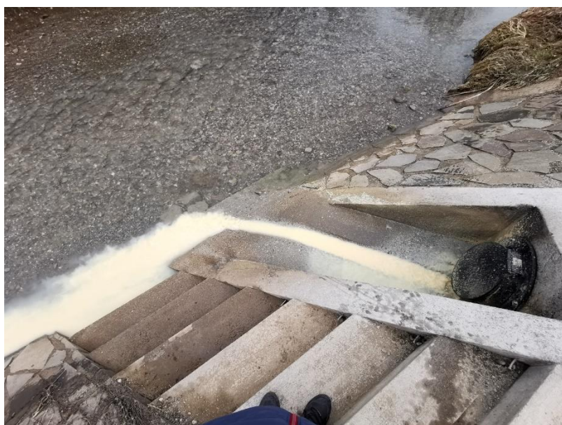
Fotografia č. 6 výustny objekt do vodného toku Kamienka
