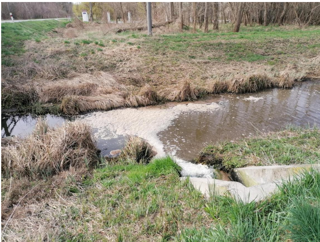
Fotografia č. 7 výustny objekt do vodného toku Lakšársky potok
