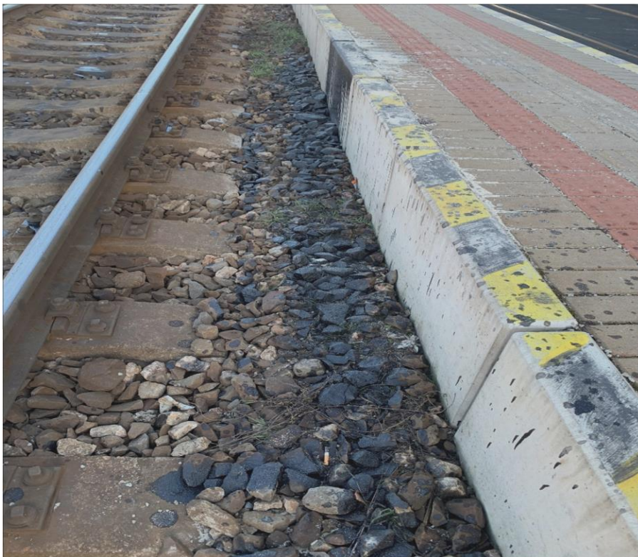
Obr. č. 3 Znečistené štrkové lôžko na koľajisku
