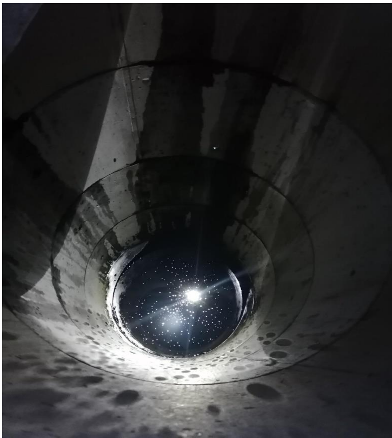
Obr. č. 6 Znečistená podzemná voda a betónové skruže / studňa dňa 26.02.2022
