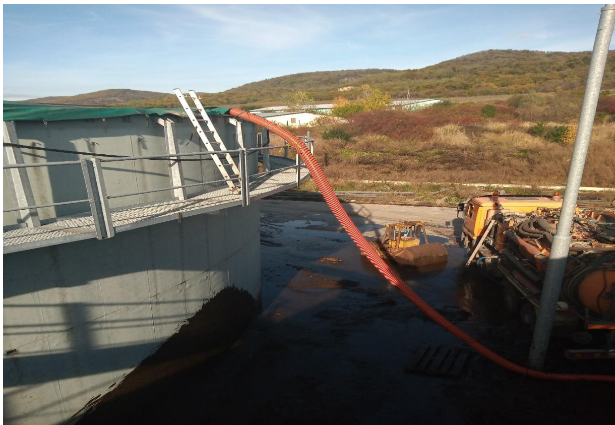
Obr. č. 9 Prečerpávanie fermentátu
