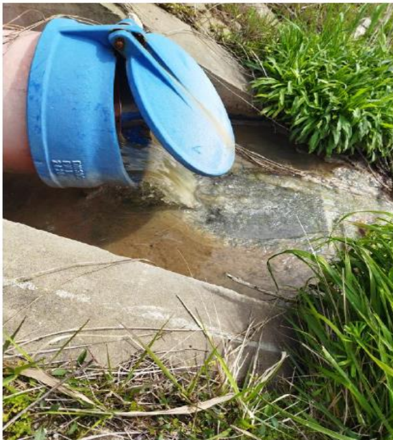
Obr. č. 6 Výustný objekt ČOV Dvorníky
