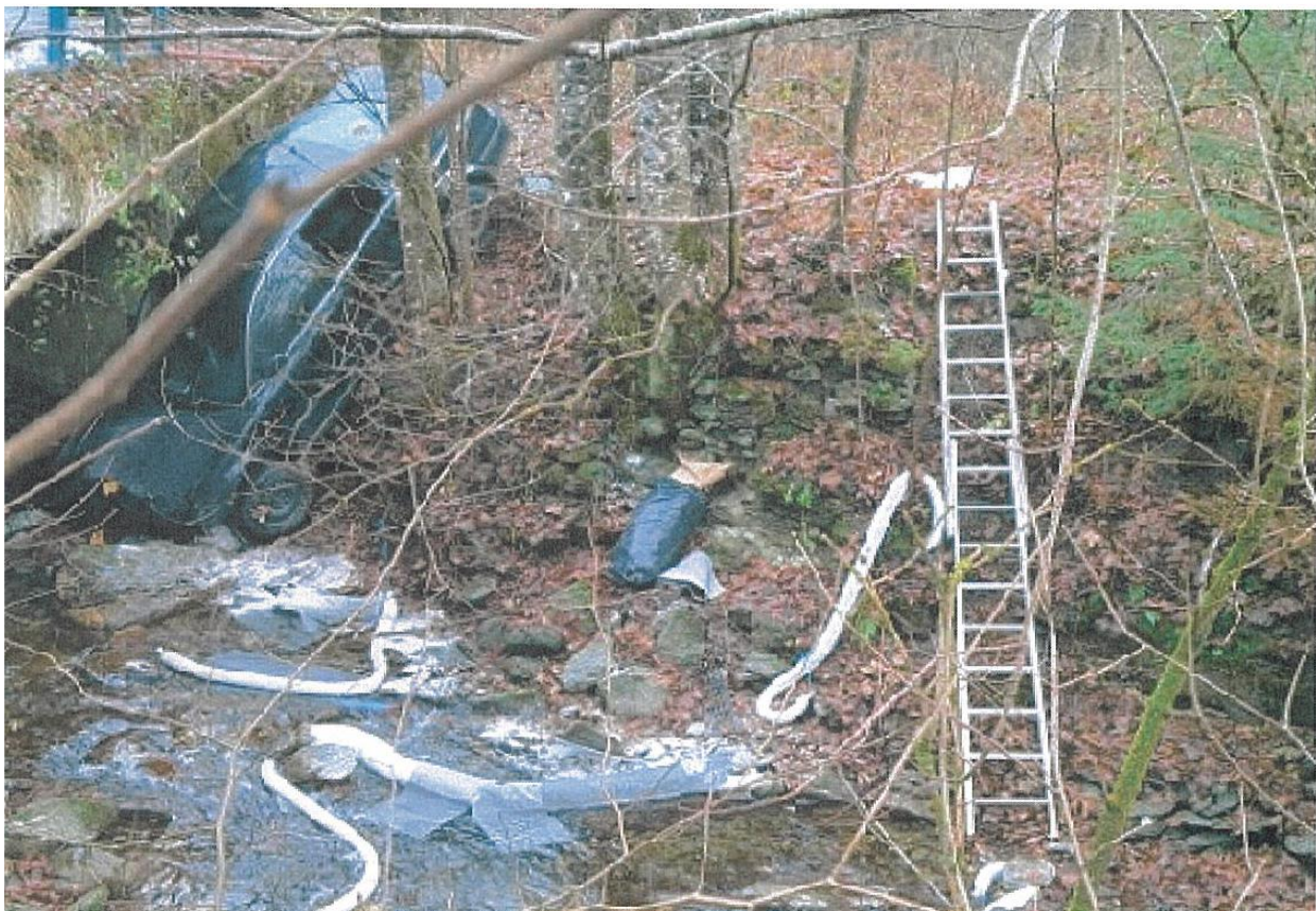
Obr. 1 Znečistenie vodného toku Súľovský potok ropnými látkami, osadenie sorpčných hadov
