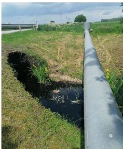
Obr. 6 Znečistenie Kolárovskeho kanála - nelegálny výustný objekt
