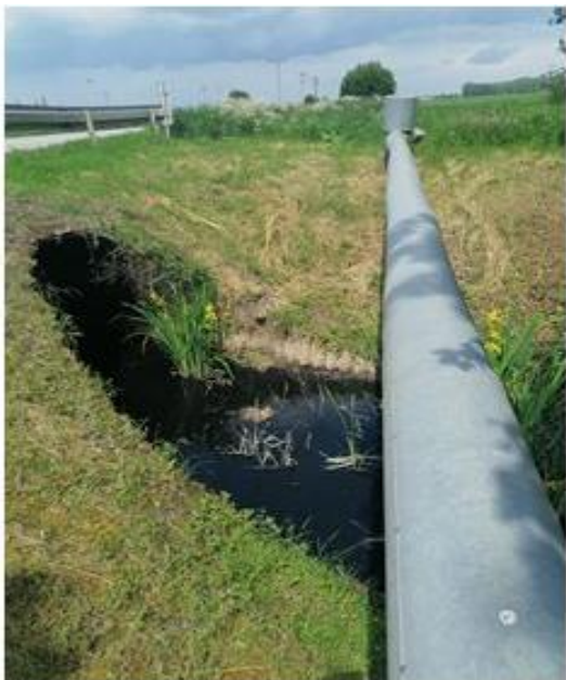
Obr. 6 Znečistenie Kolárovského kanála - nelegálny výustný objekt
